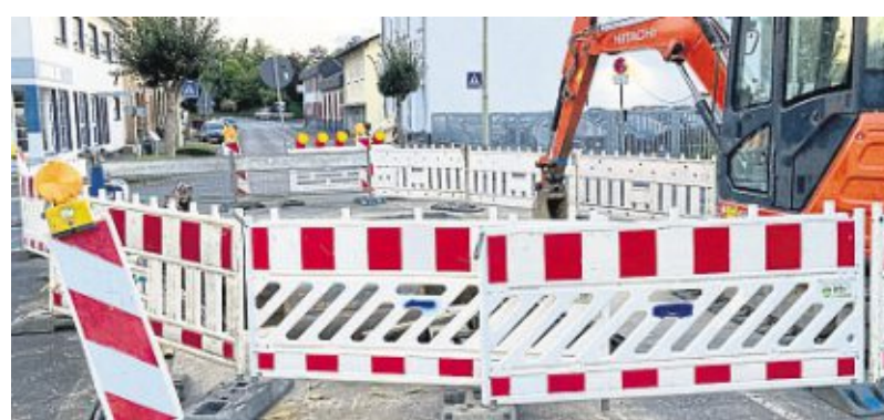
Die Baustelle in der Bahnhofstraße in Wirges dauert noch bis Freitag, 28. Juli, an, die Sperrung bleibt bestehen. Foto: Maja Wagener
